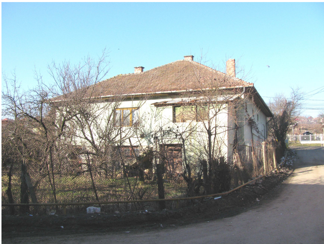
Fațadă posterioară construcție existentă
