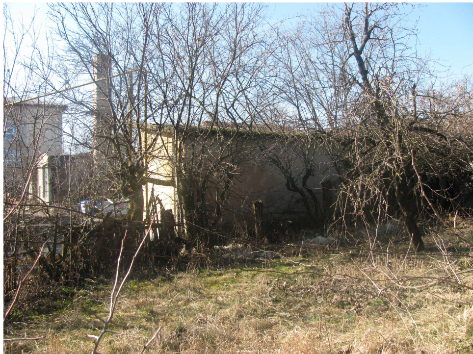
Anexa, construcție situată pe teren Liceul Pedagogic
