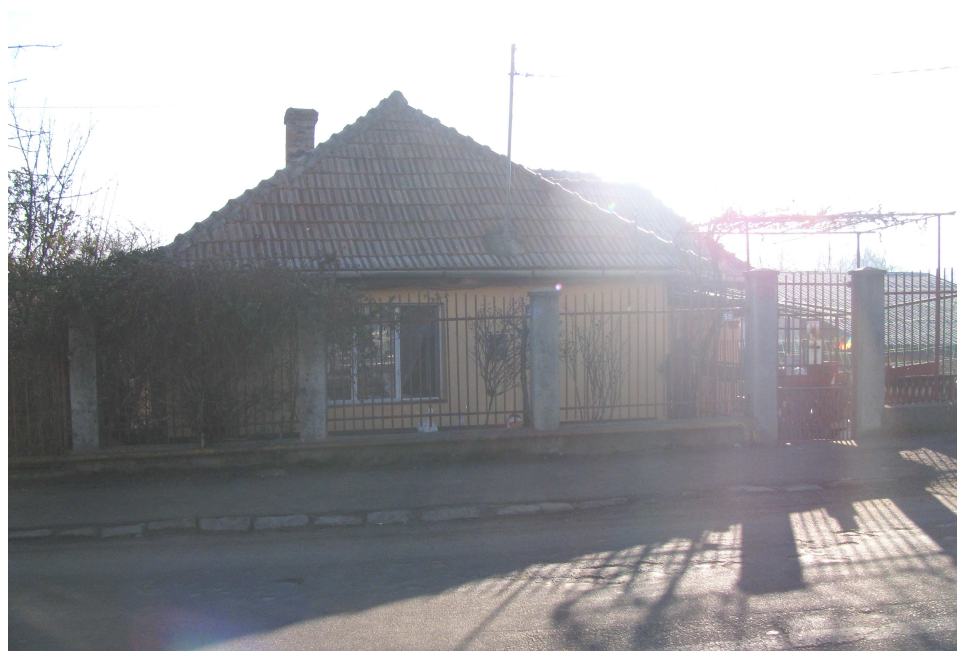
Casa existentă strada Closca, nr. 50, proprietar Gurzau Vasile
