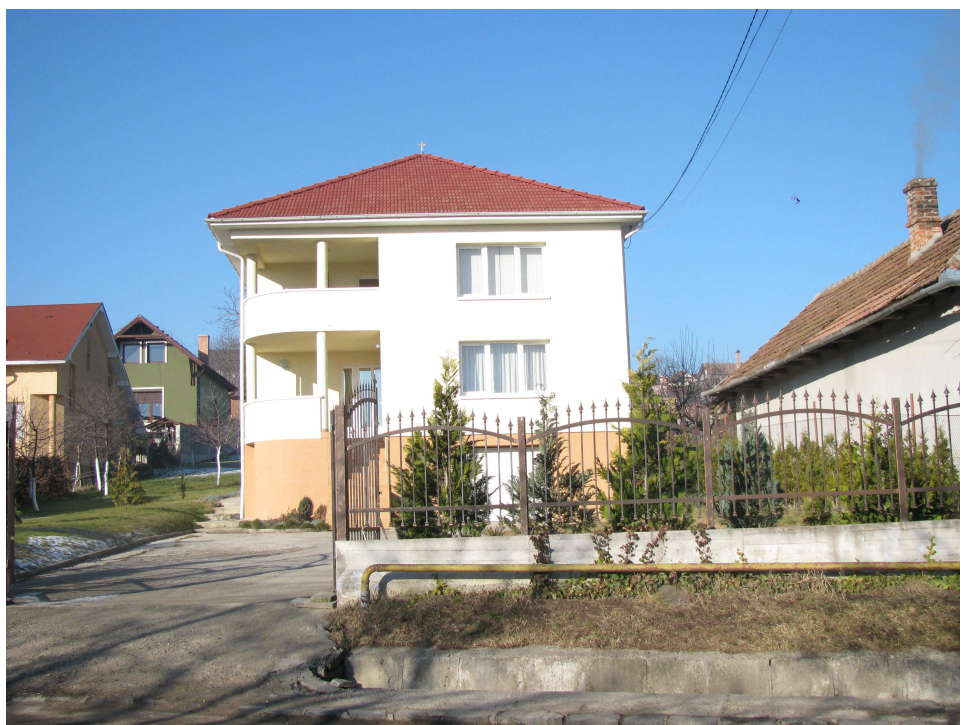
Casa existentă la strada Cloșca, nr. 55, vis-a vis de zona studiată
