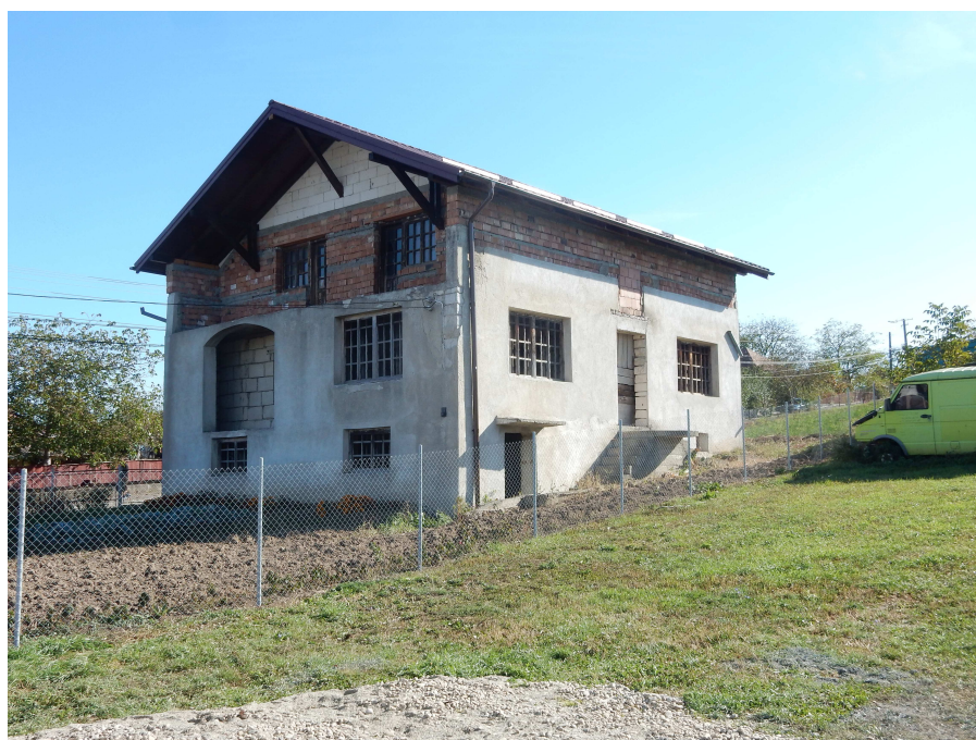
Construcție învecinată existentă la nr. 22
