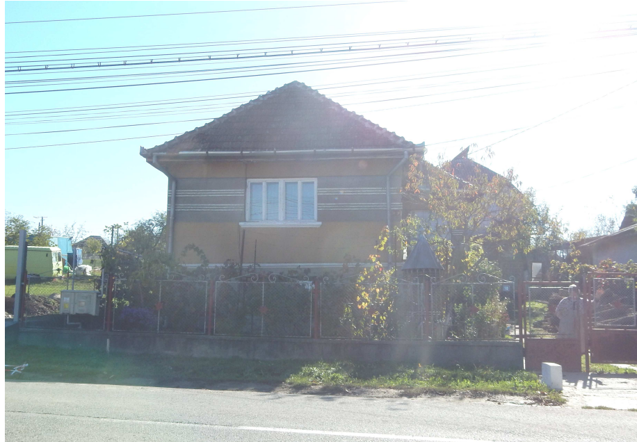
Construcție învecinată existentă la nr. 18
