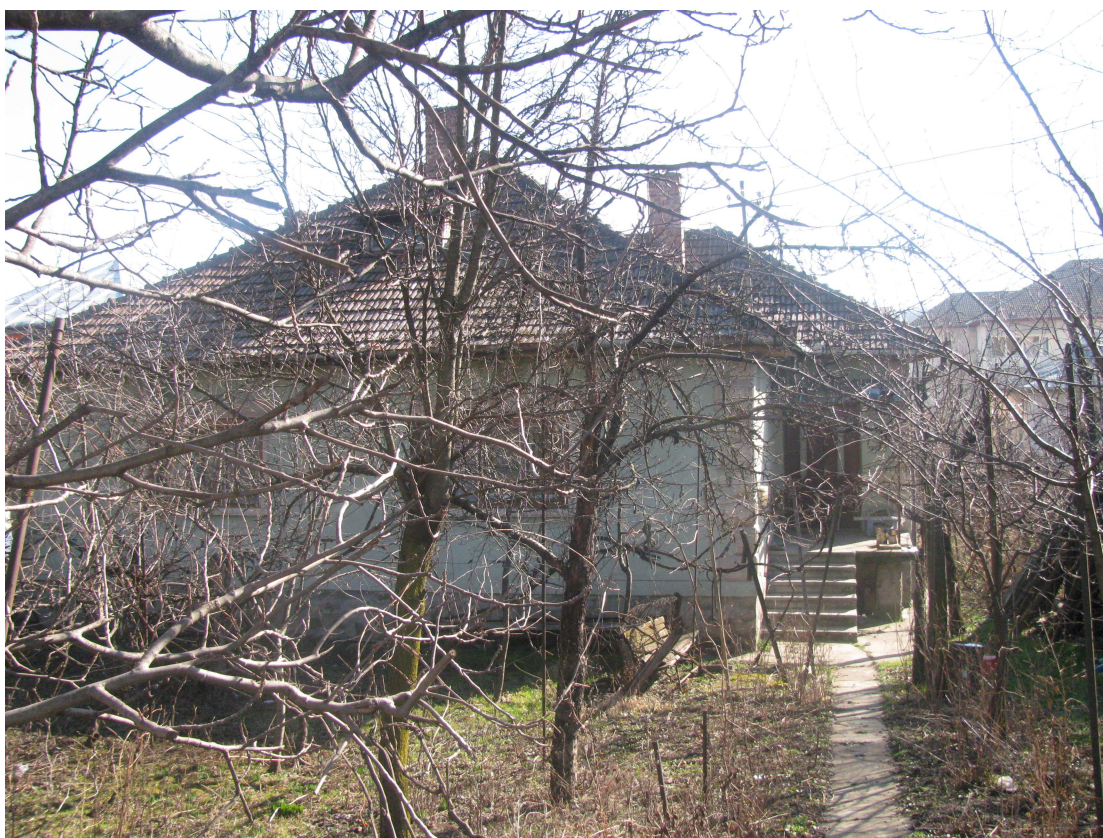
Fațadă principală construcție existentă
