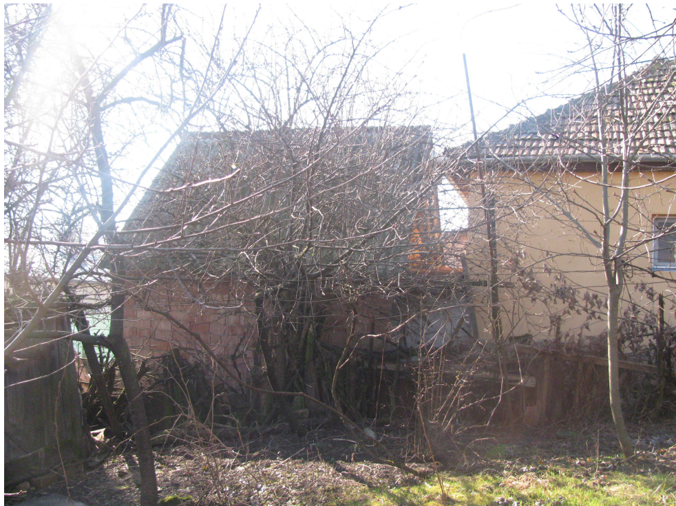
Anexă gospodărească existentă
