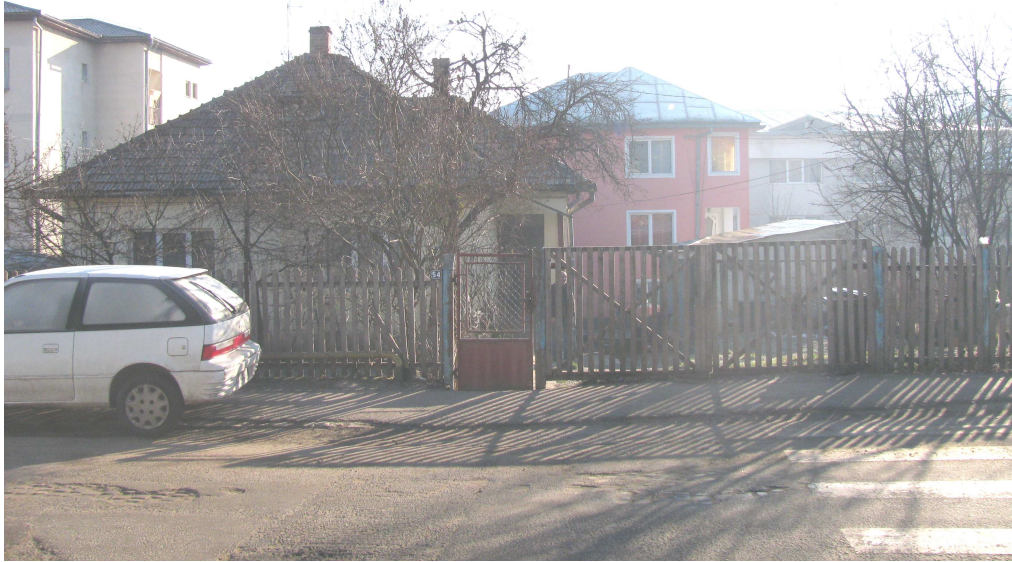
Casă existentă strada Cloșca, nr. 54, proprietar Criste Vasile
