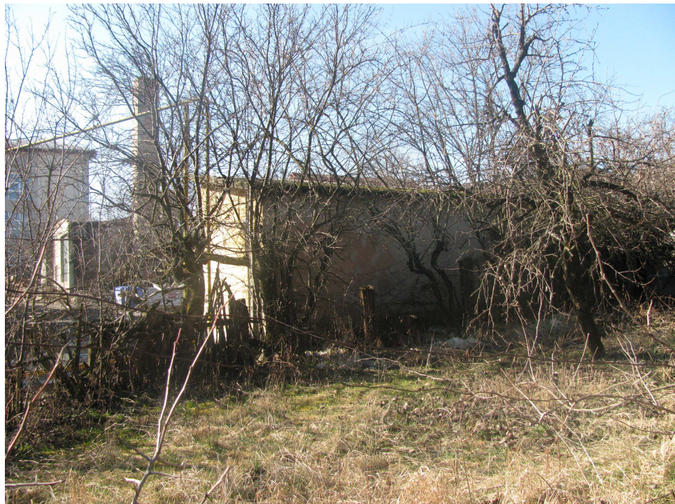
Anexa, construcție situată pe teren Liceul Pedagogic
